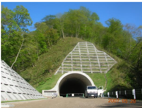
写真4 オビラルカトンネル（厚真側）
