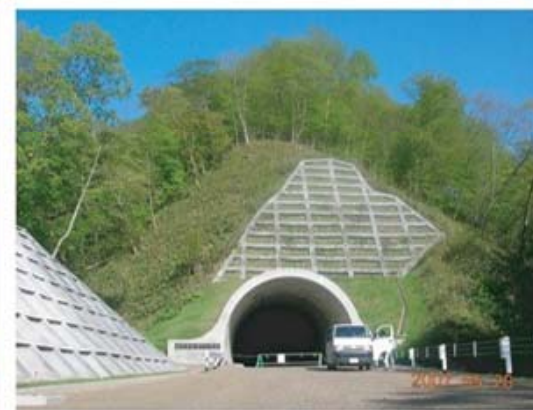
オビラルカトンネル（厚真側）
