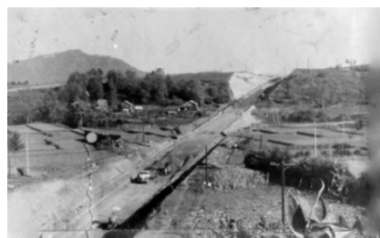
旧簾舞通行屋周辺掘削工事(昭和35)
