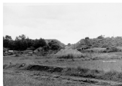
黒岩家畑・V字切土と跨道橋(昭和34)
