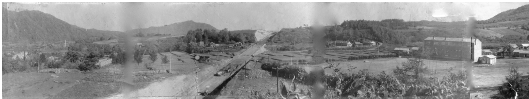
国道230号改良工事 簾舞 (昭和35)
