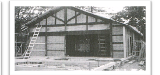
復元中「旧棟・通行屋」(昭和60年)
