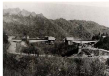
「盤の沢橋」の建設中(昭和35)
