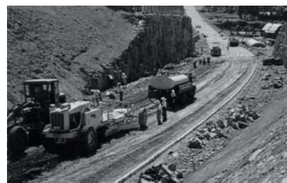
簾舞二星岱の岩壁下舗装工事(昭和36)
