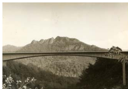
完成した「盤の沢橋」(昭和36)
